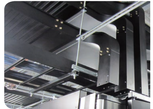
Cablofil fiber optic slot installation for critical cabling Cablofil 光纤槽安装用于关键布线。
